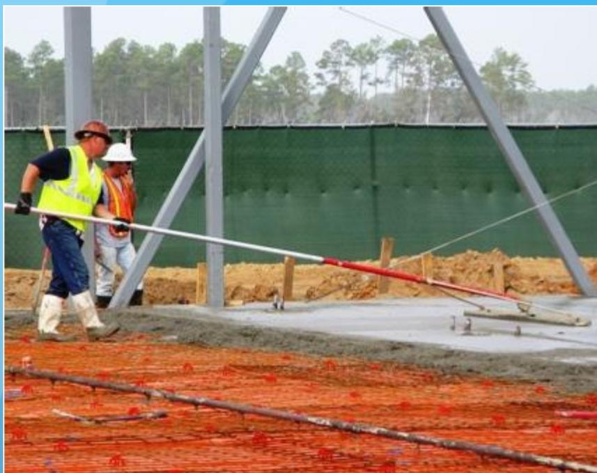
Рисунок 2 – Разравнивание бетона специальными граблями
