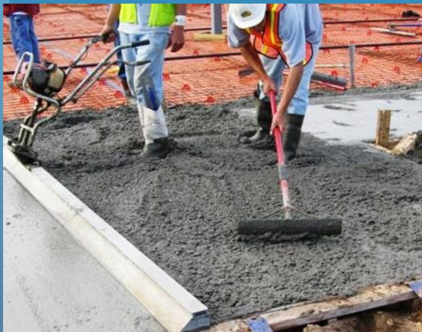
Рисунок 1 – Прием и укладка бетона
