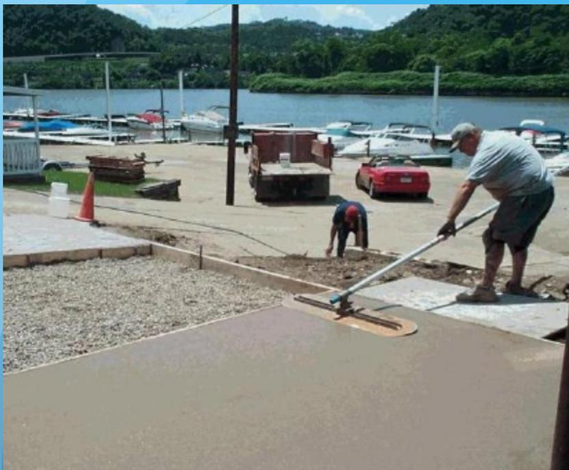
Рисунок 5-Разглаживание поверхности гладилкой
