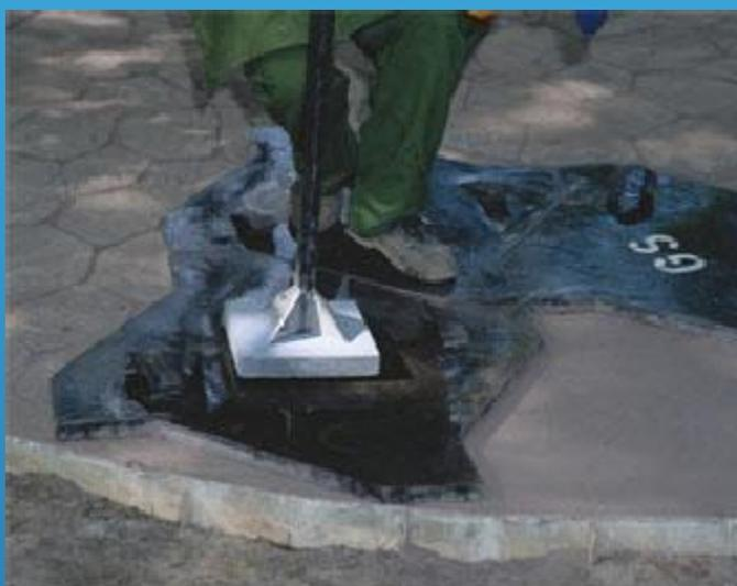
Рисунок 8 - Отпечатывание поверхности бетона с применением текстурных форм
