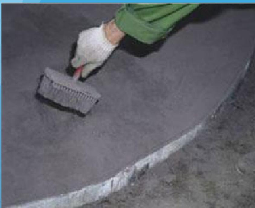
Рисунок 7- Нанесение агента-разъединителя
