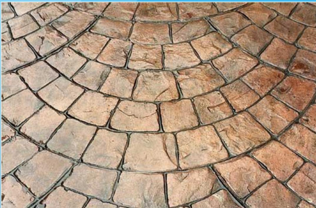
Рисунок 11 - Готовая поверхность после нанесения защитной пропитки
