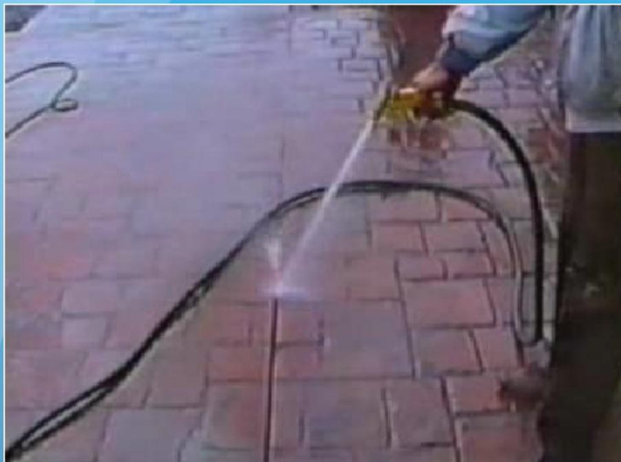
Рисунок 10 – Смывка агента-разъединителя с помощью шланга
